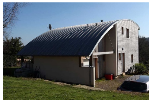
Exemple de toiture courbe
